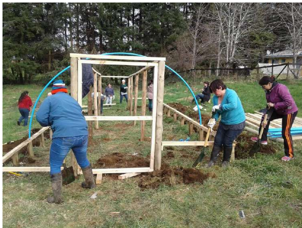
Construcción colectiva de invernadero en LaPoza. Año 2017.
