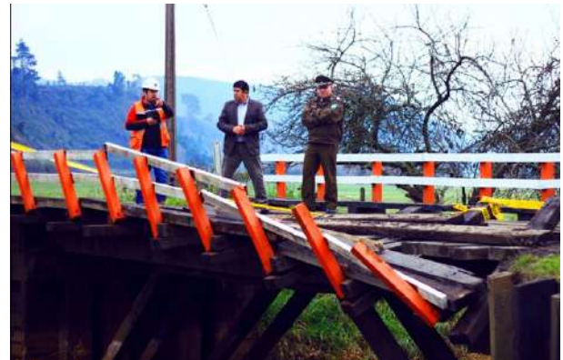
Puente Trumao 1, Ruta U-100
